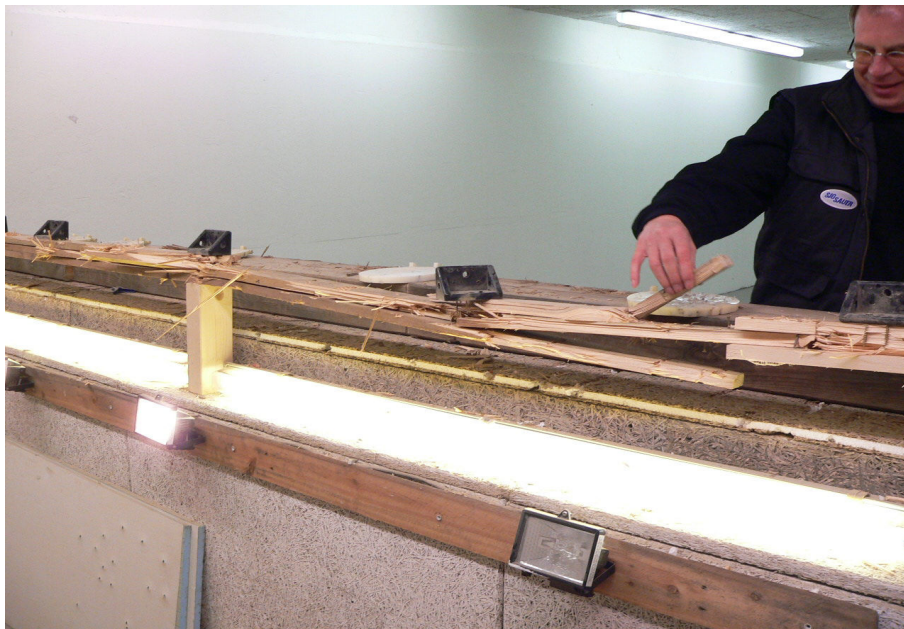
kleine Umbaumaßnahmen sind erforderlich..
