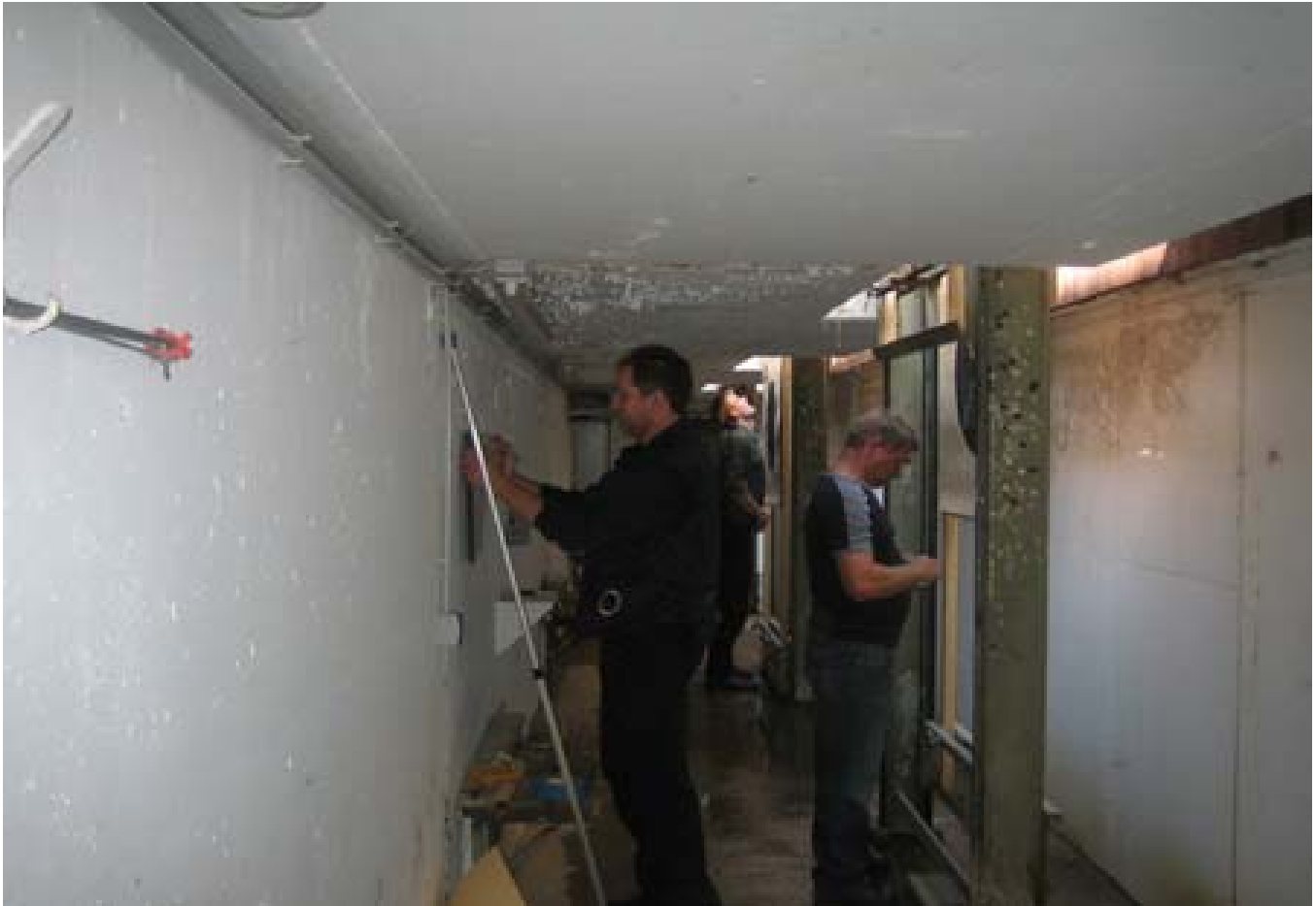
Deckungsarbeit, ohne sie geht bei 300 Meter nichts
