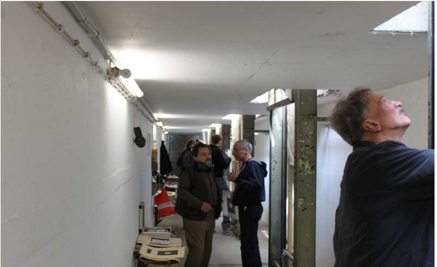
Arbeit in der Deckung
